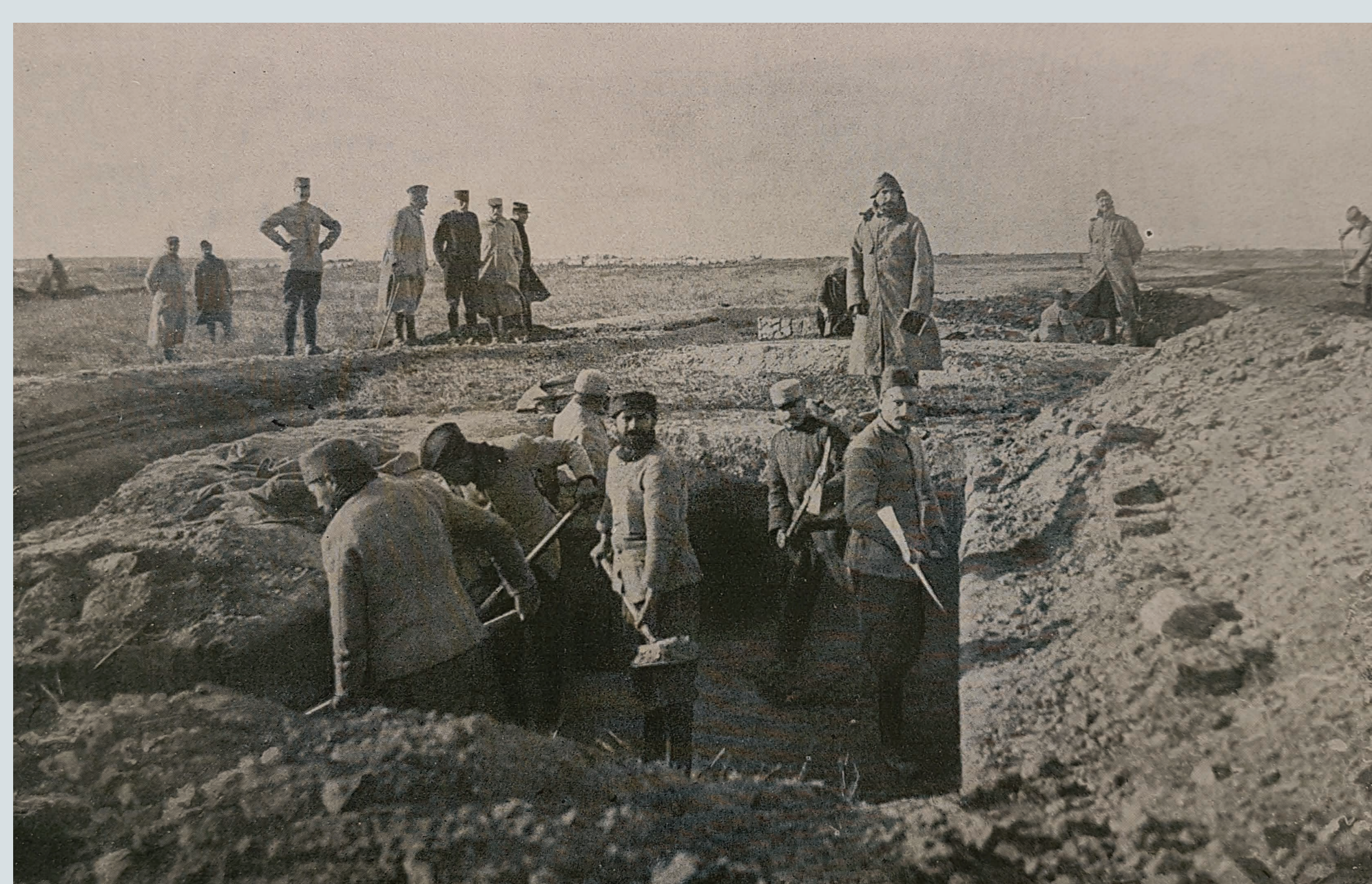
Les soldats creusent les tranchées sous l'œil du général Sarrail photographiés par Hubert Jacques
